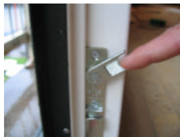
Tappene bevæges en halv omgang mod urets retning. Tappene er her vist på døre i tagboligen. På de øvrige etager er tappene noget længere.
