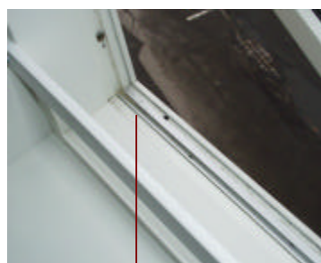
Glideflade i bunden. Rengøres og påføres teflonspray.
