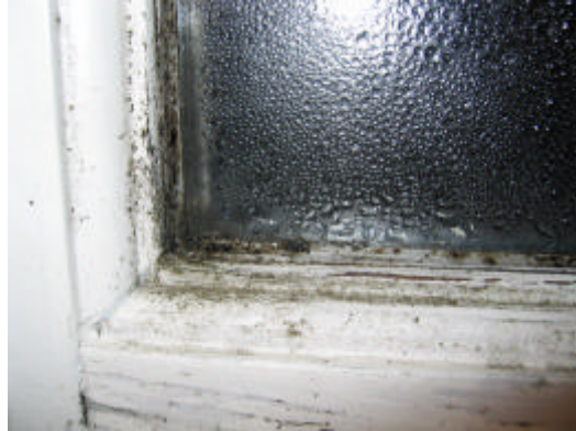
Vindue angrebet af skimmelsvamp pga. manglende udluftning. Fotoet er ikke fra det hvide snit.
