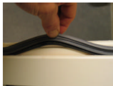
Tætningslisten kan forsigtig hives ud, når der skal males på indv. side.
