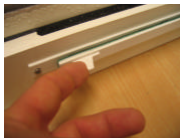
Skub den hvide tap ind mod midten af vinduet, så åbnes friskluftventilen.
